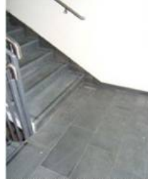
Foto 14. Detalj skiferfliser på trapp og sokkellist
