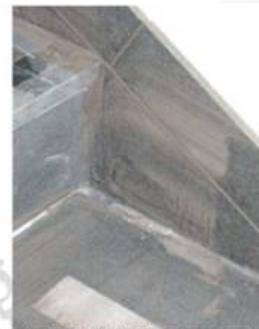
Foto 15. Detalj skiferfliser på trapp og sokkellist
