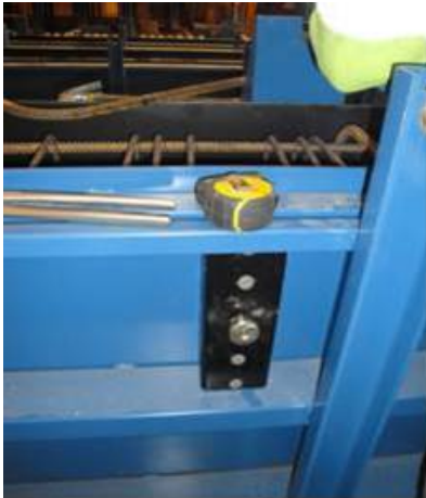
4.1 Eksempel på festing med magnet til stålform
