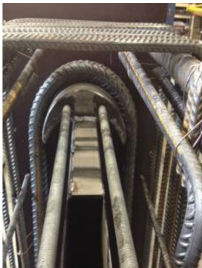
5.1 Bjelkeenheten plassert inn i armering
