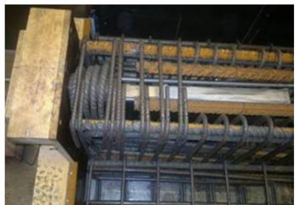
4.6 BSF-enhet på plass i støpeform
