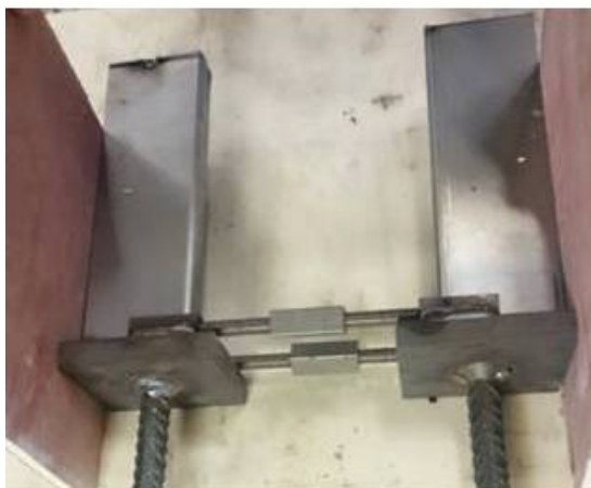
2.3 Det er også mulig å benytte kortere gjengestenger og gjengehylse for å skjote disse
