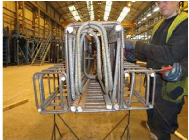
4.2 Klar for innfesting av bjelke enhet, legg merke til strips på toppbøylene for enklere å få inn bjelkeenhets
