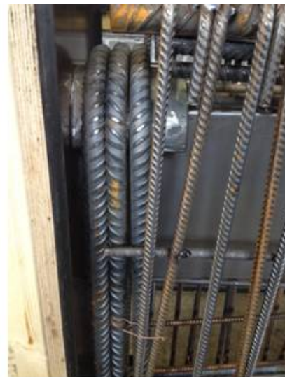
5.2 Bjelkeenheten plassert inn i armering
