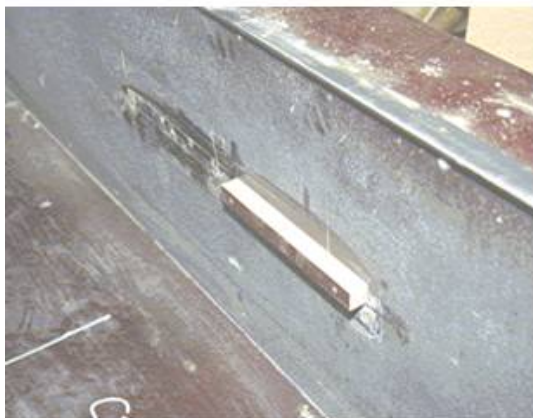
2.5 Styrekniv sikrer nøyaktig plassering av enheten NB! Viktig
