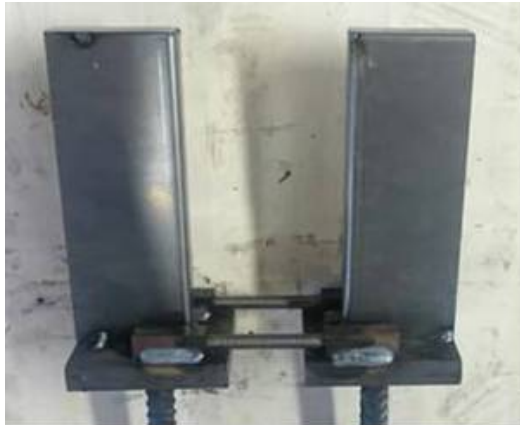
2.1 Tosidig søyleenhet med gjengestenger som holder de sammen
