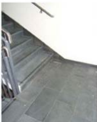
Foto 14. Detalj skiferfliser på trapp og sokkellist
