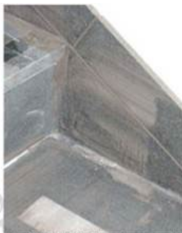
Foto 15. Detalj skiferfiser på trapp og sokkellist
