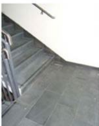
Foto 14. Detalj skiferfiser på trapp og sokkellist
