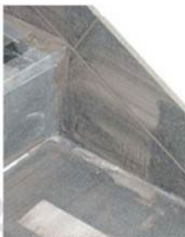
Foto 15. Detalj skiferfliser på trapp og sokkellist
