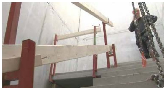
M24: Trappeavsats ferdig og klar for neste
