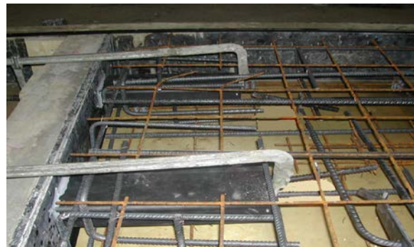
P2: TSS fastsatt med tvinge i støpeform
