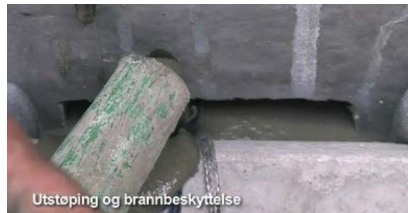
M14: Fylling av mørtel og brannbeskytter
