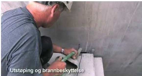
M13: Fylling av mørtel rundt enhetene
