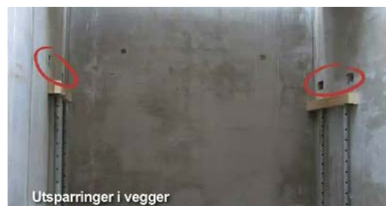
M4: Støtter for repos, justert til riktig høyde.
