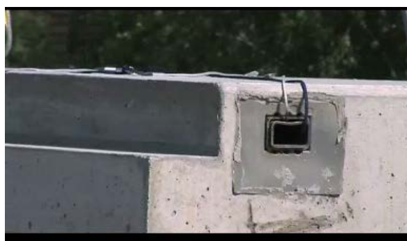
M3: Legg tauene tilrette, før repos heises på plass
