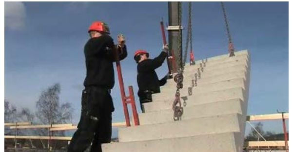
M18: Montering av rekkverk på trappen
