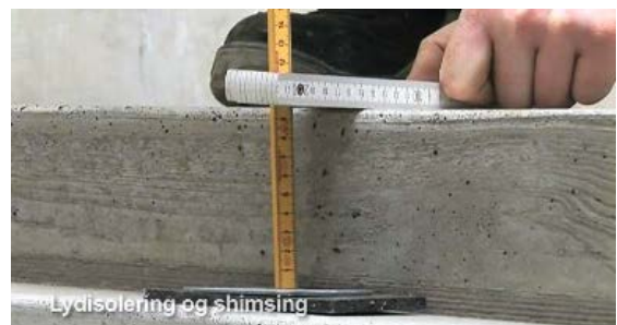
M20: Shimsing til riktig høyde for trappe elementet
