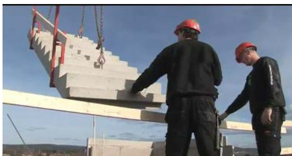
M21: Trapp blir heist på plass
