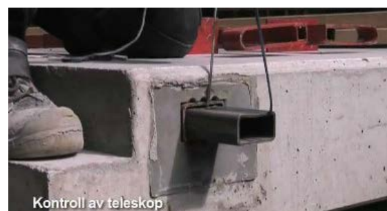
M2: Før montering bør det sjekkes at innerrøret glir fint inn og ut.
