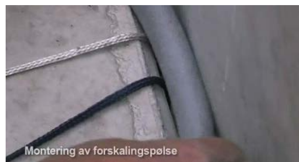
M8: Montering av bunnfyllingslist rundt enhetene.
