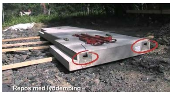
M1: Repos med TSS og vertikal gummiflens klar til montering
