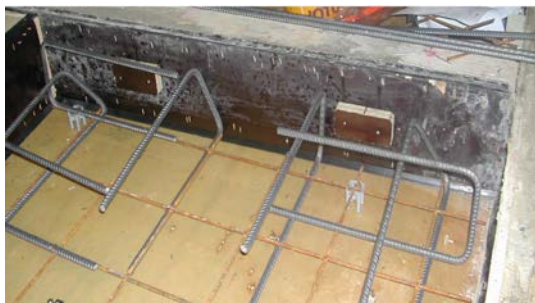
P1: støpeform med styreklosser
