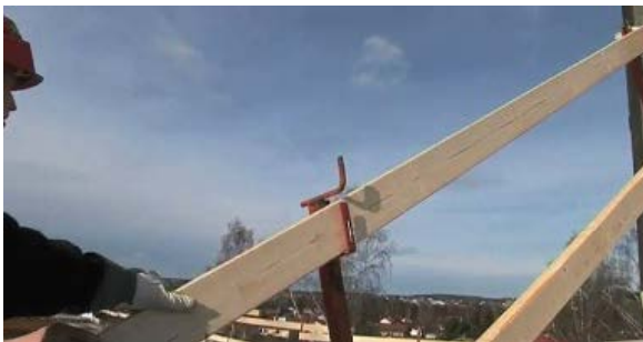
M19: Rekkverk montert
