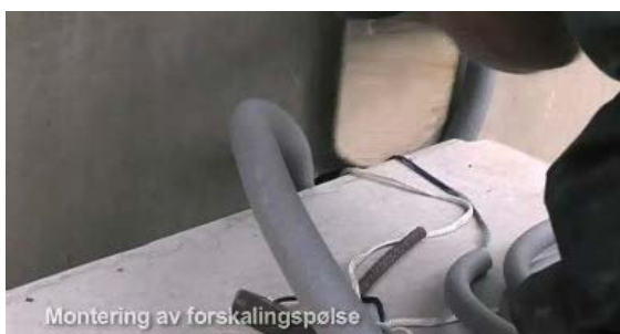
M9: Bruker en jigg for å dytte bunnfyllingslisten til riktig posisjon
