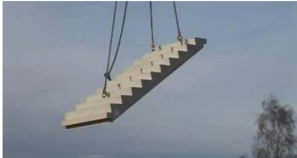
M17: Trapp heises på plass
