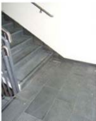
Foto 14. Detalj skiferfliser på trapp og sokkellist
