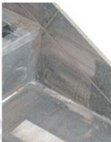
Foto 15. Detalj skiferfliser på trapp og sokkellist
